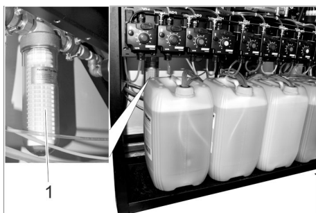
1 Filter frostskyddspump
